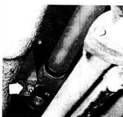
Снятие упругой промежуточной опоры. Стрелкой показан болт крепления поперечины опоры к полу кузова
